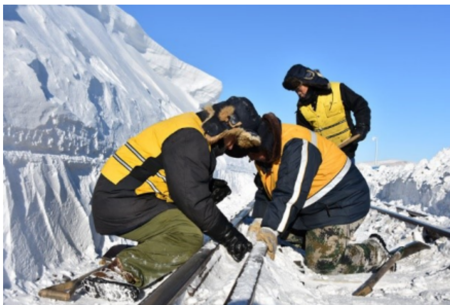
图 5 室外雪天情况下铁路设备
